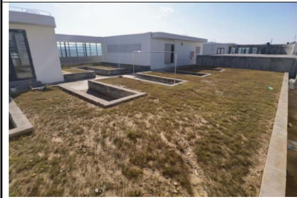
余杭楼顶点（片）状撒播种草绿化
