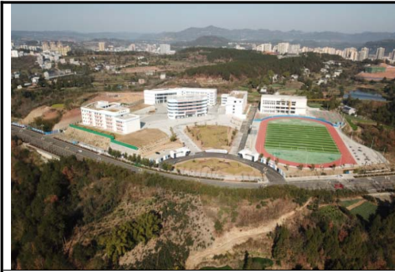
项目建设现状
