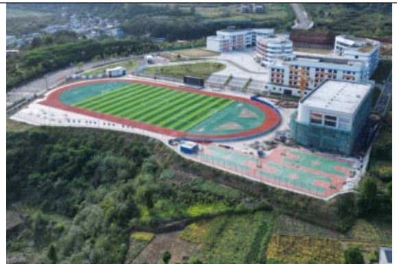
运动场东侧回填边坡撒播中草绿化
