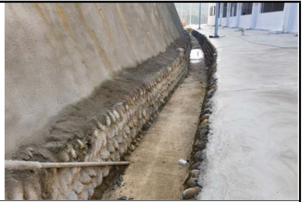
体育中心后的雨水排水沟
