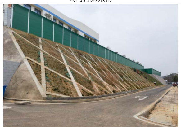
地块西侧开挖边坡砼框格护坡
