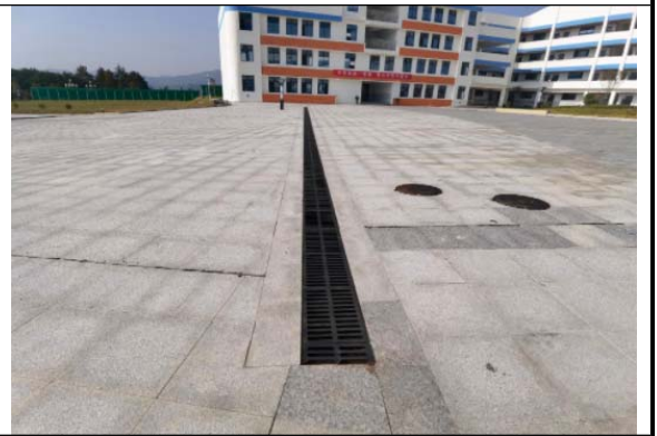
铸铁盖板排水沟
