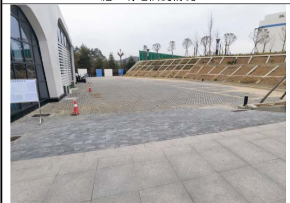
铺砼空心砖生态停车场
