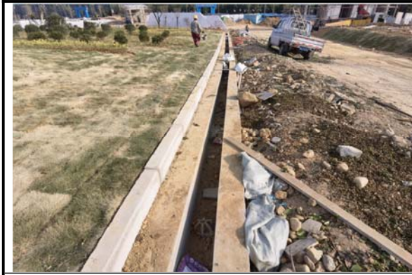
修建的排水沟 2023.05.30
