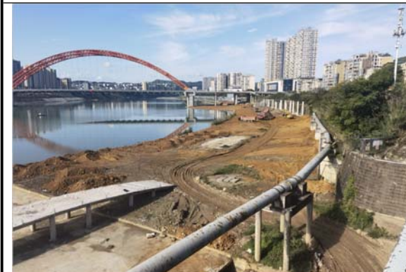
开挖料运至滨江绿道项目回填利用 2022. 10. 30
