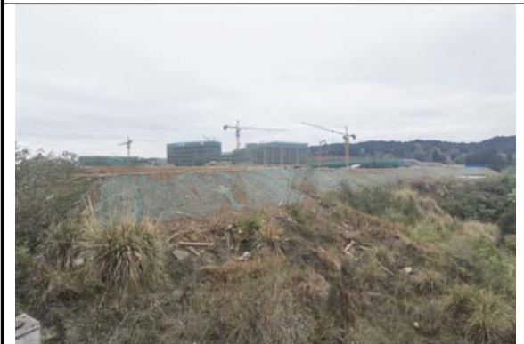
运动场东南侧填方边坡遮盖 2023.03.30
