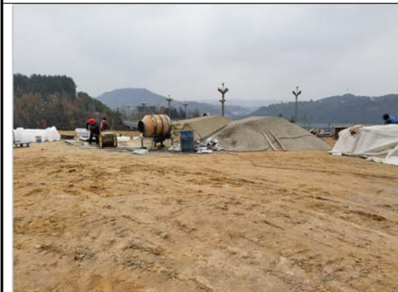
排水沟盖板预制场 2022. 12. 30
