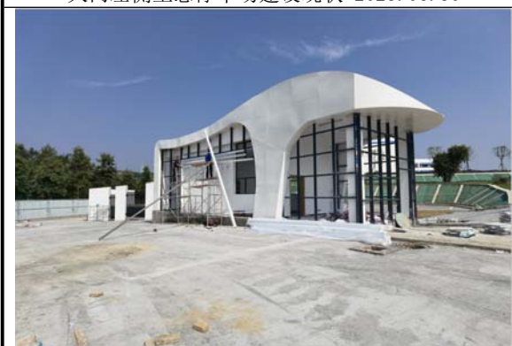
值班室建设现状 2023.07.30
