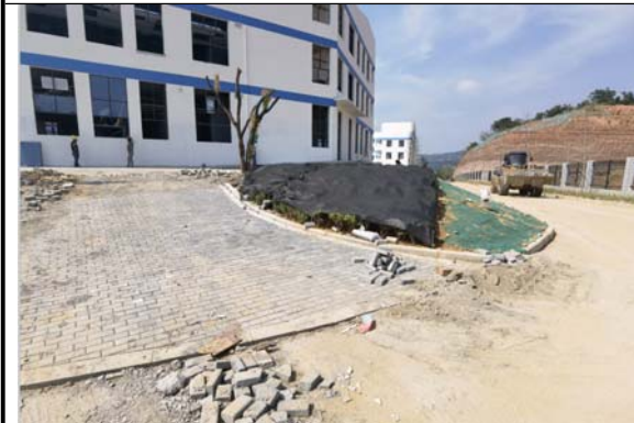
食堂建设现状 2023.07.30
