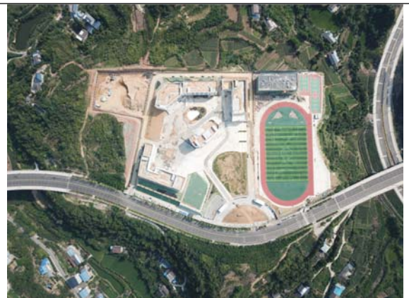
项目建设现状 2023.07.30
