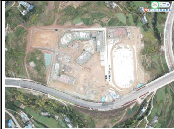
项目建设现状俯视图
