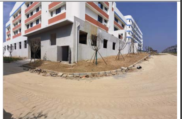
小学教学楼建设现状 2023.07.30
