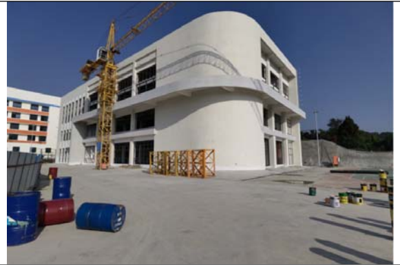
体育馆建设现状 2023. 11. 30
