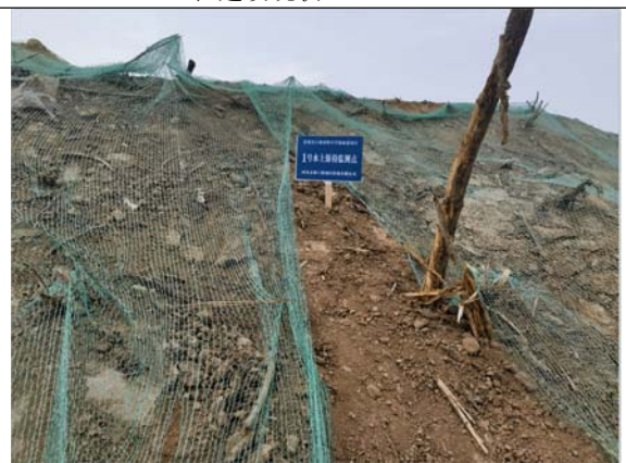
运动场东南侧填方边坡 1 号监测点 2023. 02. 28
