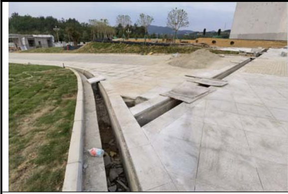
铺装及排水沟 2023.06.30
