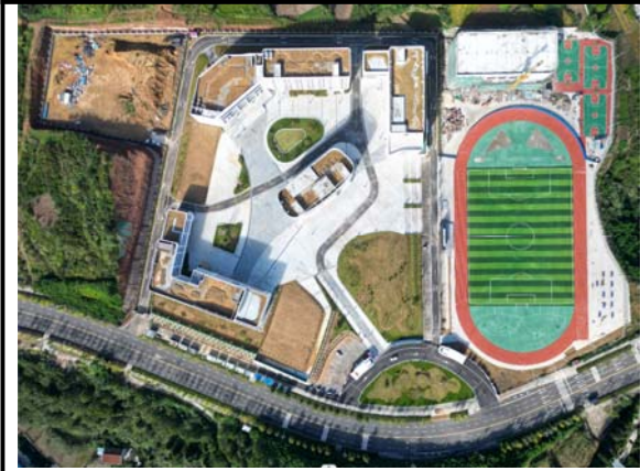
项目建设现状
