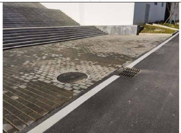
雨水检查井、雨水口
