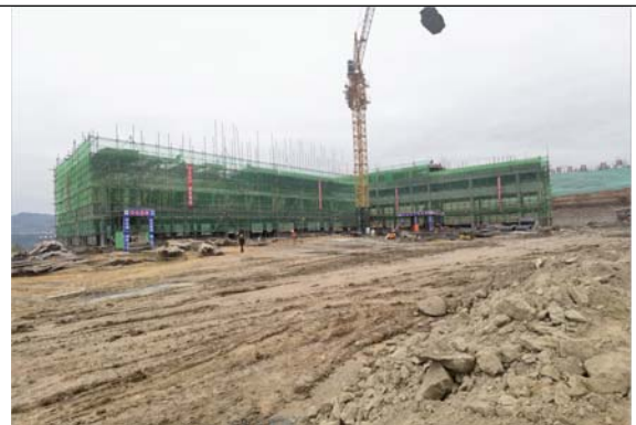
中学教学楼建设现状 2023.03.30
