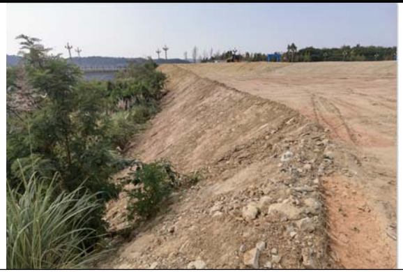
东南侧填方边坡 2022. 10. 30
