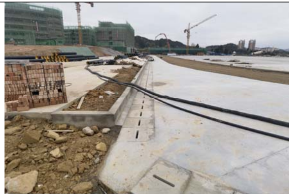
运动场建设现状 2023.03.30
