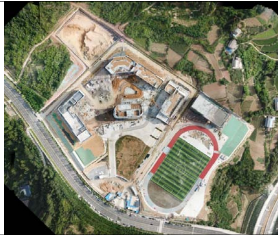
项目建设现状 2023.06.30
