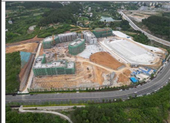
项目建设现状 2023. 04. 30
