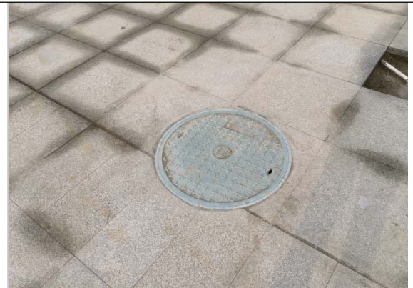
建设的检查井 2023.06.30
