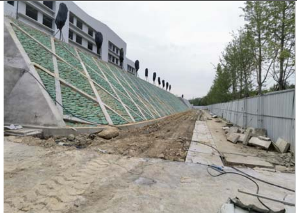
采取砼框格梁护坡
