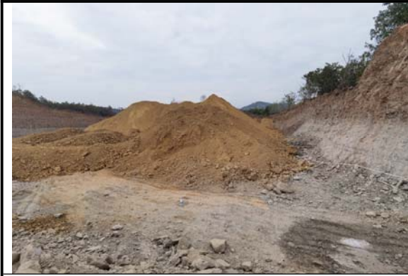
在拟建幼儿园临时堆土 2022. 11. 30
