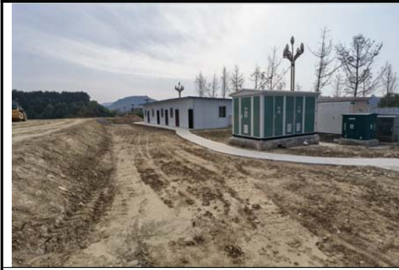
项目施工用电设施 2022. 10. 30
