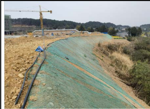
运动场东南侧填方边坡遮盖 2023. 02. 28
