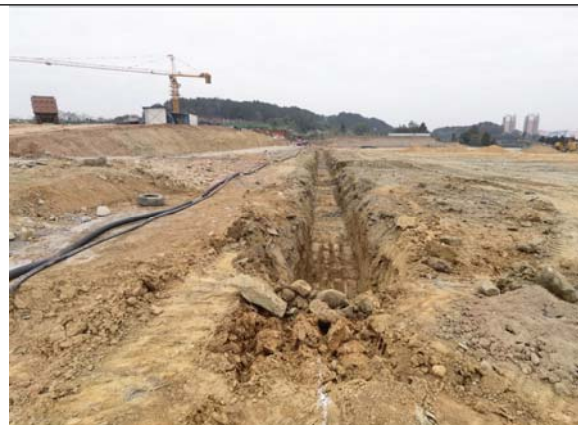
安装雨水排水管 2022. 11. 30
