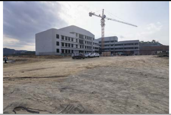
中学教学楼建设现状 2023.05.30
