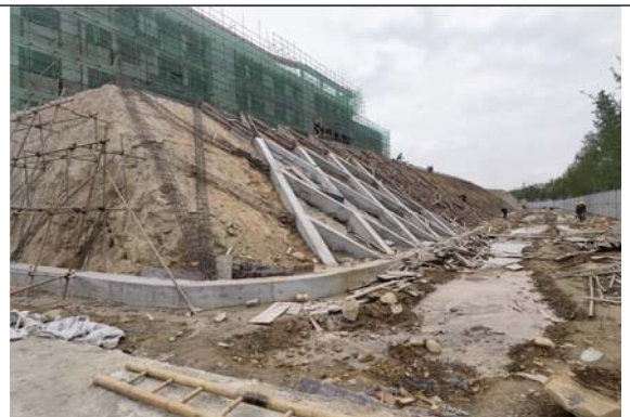
中学教学楼侧开挖边坡框格梁琥珀 2023. 04. 30
