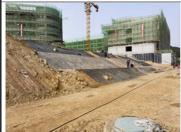
综合楼至运动场通道修建情况 2023. 02. 28
