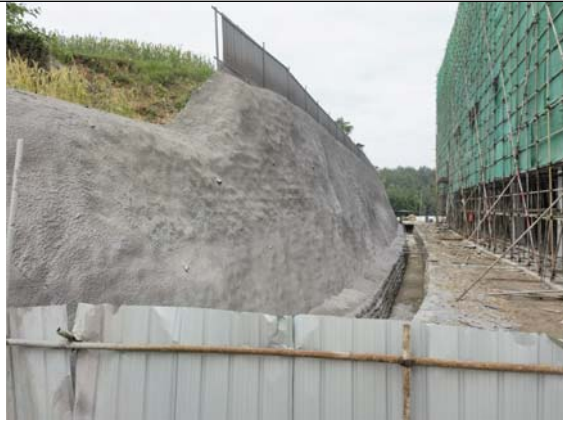
采取喷浆防护的开挖边坡及排水沟
