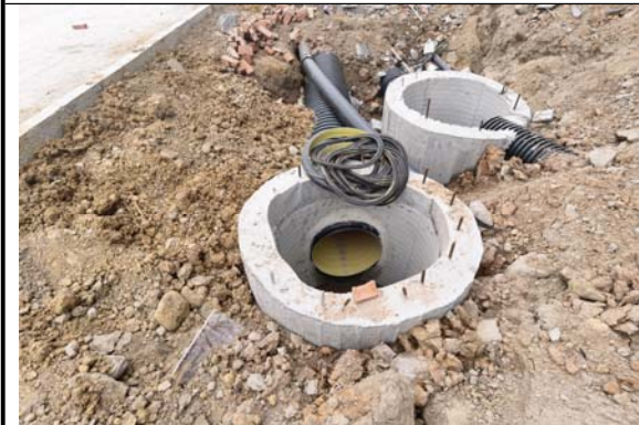
建设中的雨水检查井及雨水管管 2023. 04. 30
