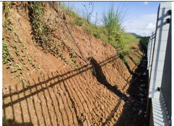
需采取管理、防护措施的开挖边坡
