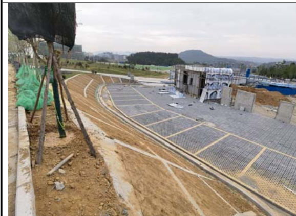
大门左侧生态停车场建设现状 2023.06.30
