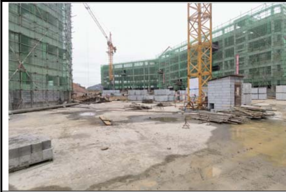
小学教学楼建设现状 2023. 03. 30
