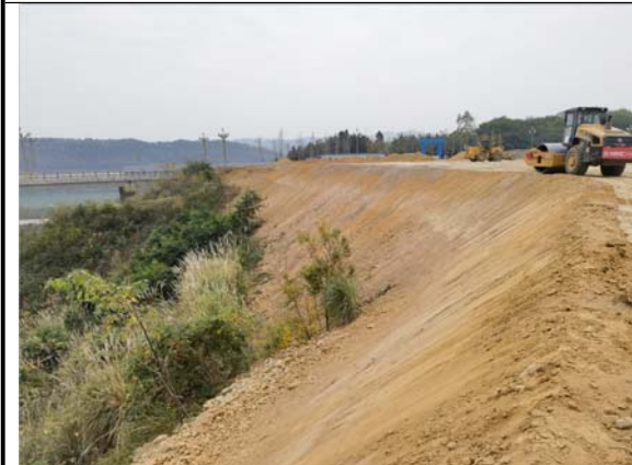
东南侧填方边坡 2022. 11. 30
