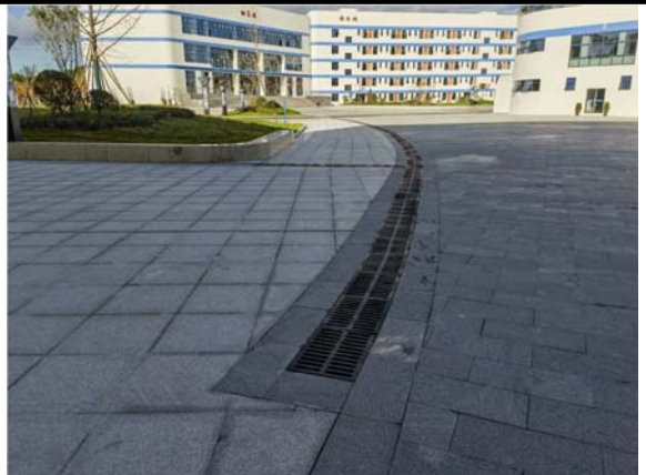
建成的排水沟
