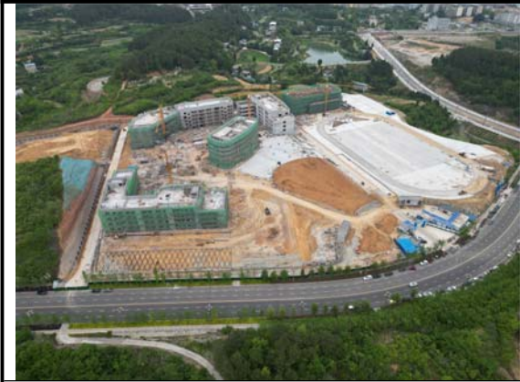
项目建设现状
