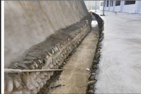
体育馆后的排水沟 2023. 11. 30
