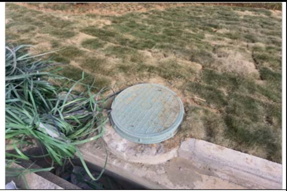
修建的雨水检查井 2023.05.30
