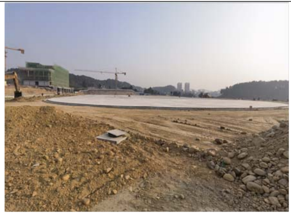
全民建设中心建设现状 2023. 01. 30
