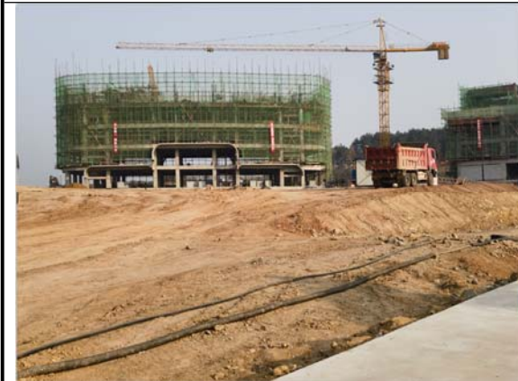
教学综合楼建设现状 2023. 01. 30
