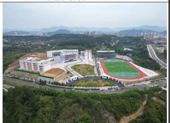
项目建设现状 2023.08.30
