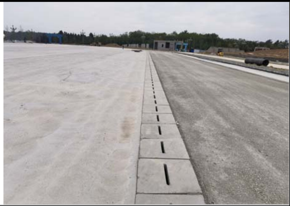
运动场盖板排水沟
