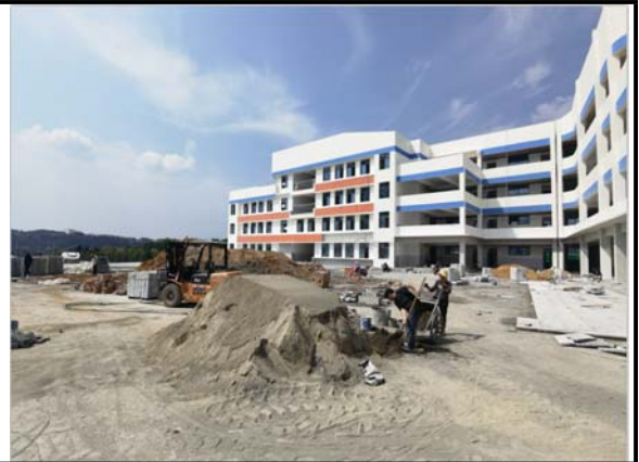
中学教学楼建设现状 2023.07.30
