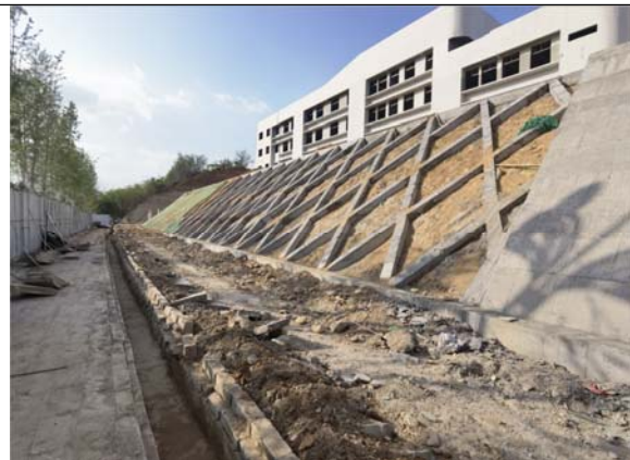
中学教学楼砼框格护坡 2023.05.30
