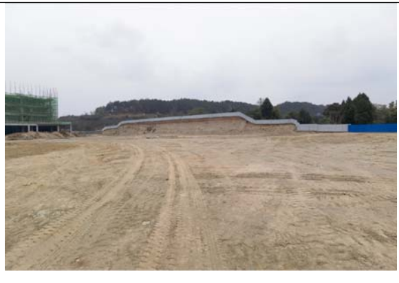
需防护的运动场北侧挖方边坡
