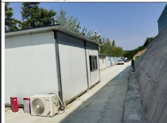
施工生产生活区 2023.07.30
