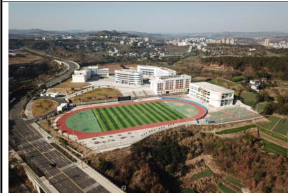
项目建设现状 2023. 12. 30
