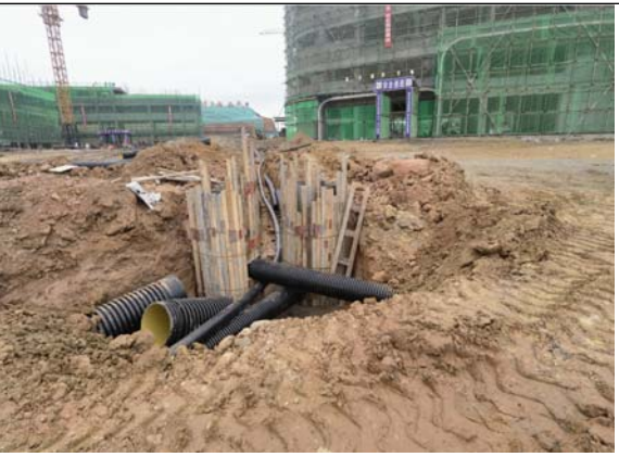
正在施工的雨水检查井
