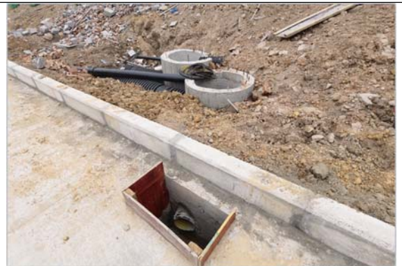
建设中的雨水口及雨水管 2023. 04. 30
