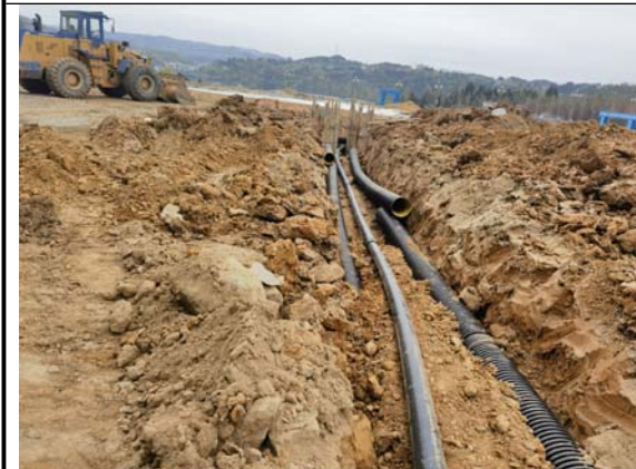
建设中的雨水管
