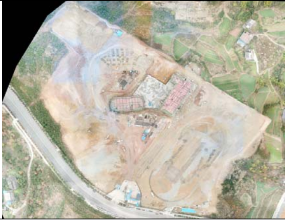
项目建设现状俯视图
