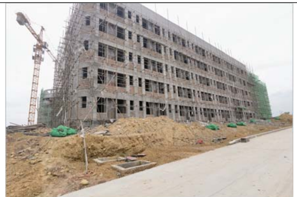
男生宿舍建设现状 2023. 04. 30
