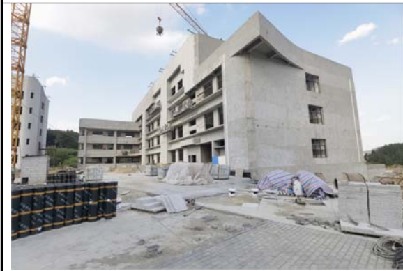
小学教学楼建设现状 2023.05.30
