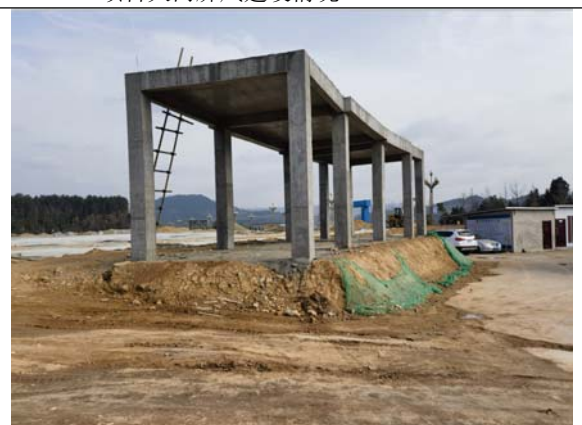
门卫室建设现状 2023. 02. 28
