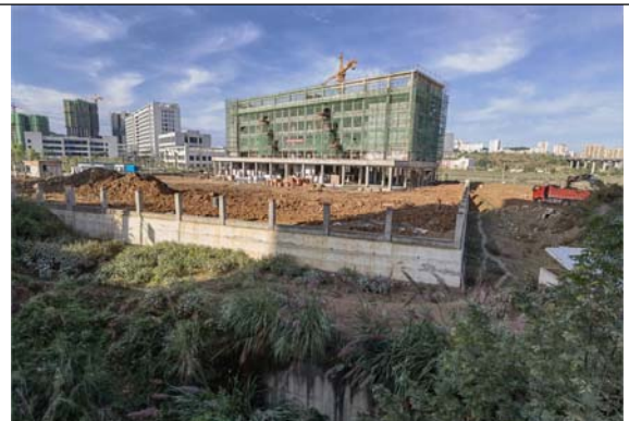
开挖料运至县人民医院项目回填利用 2022. 10. 30
