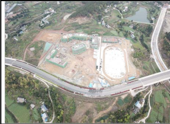
项目建设现状 2023.03.30
