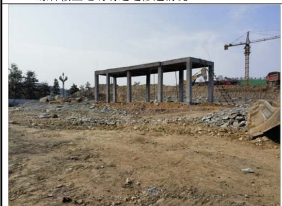
值班室建设现状 2023. 02. 28
