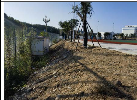
需对运动场南侧裸露地采取复绿措施
