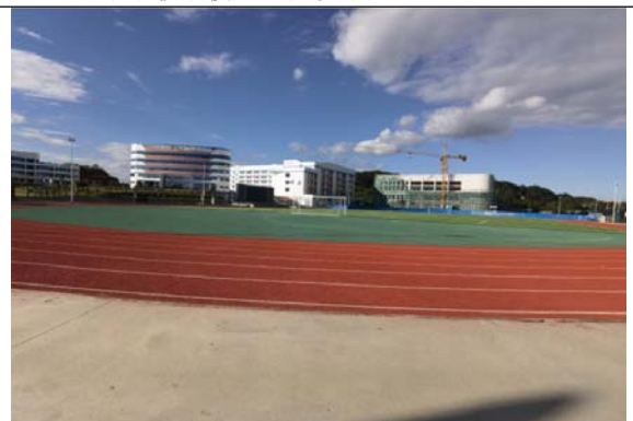
体育馆建设现状 2023.09.30
