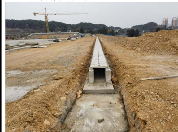
运动场盖板排水沟建设现状 2023. 02. 28
