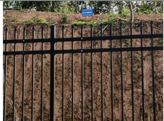
地块北侧开挖边坡 2号监测点 2023.06.30
