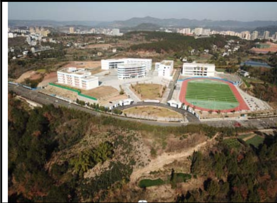
项目建设现状
