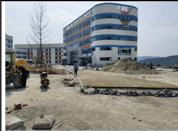
综合楼建设现状 2023.07.30
