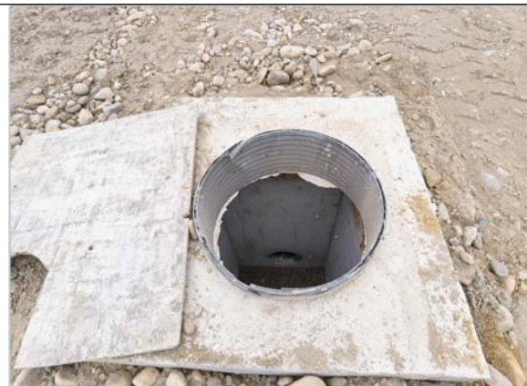
雨水排水管检查井建设现状 2022. 12. 30
