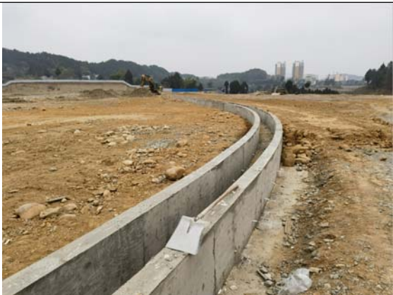
运动场排水沟
