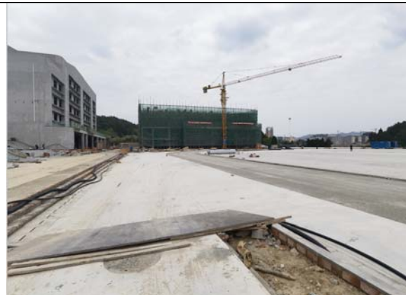
体育馆建设现状 2023. 04. 30
