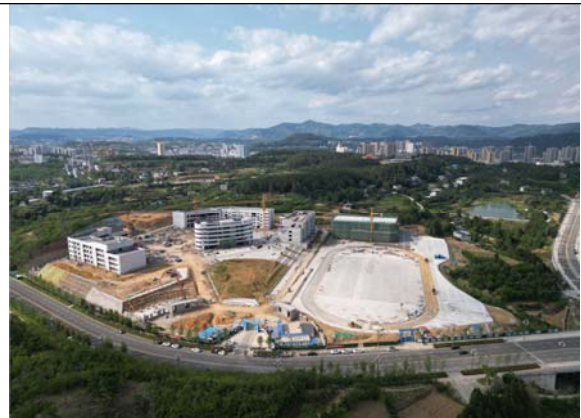
项目建设情况 2023. 05. 30
