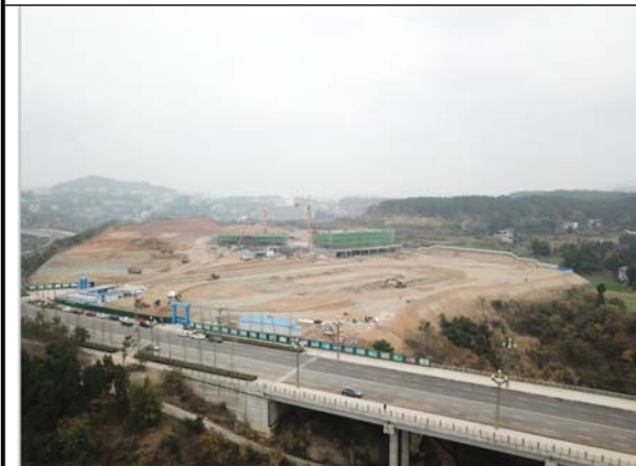
项目建设现状 2022. 12. 30
