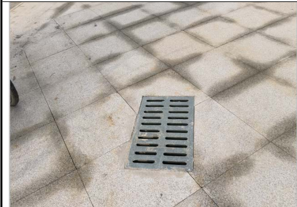
建设的雨水口 2023.06.30
