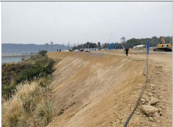
需防护的运动场东侧填方边坡
