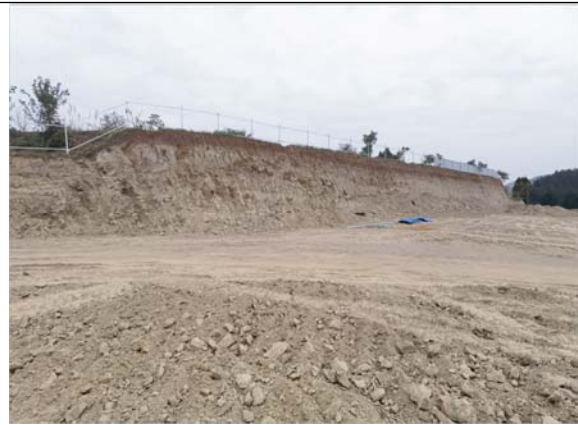
东北方开挖边坡 2022. 11. 30
