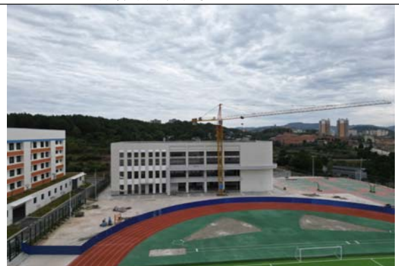
体育馆建设现状 2023.10.30
