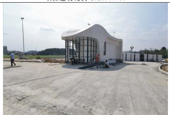
门卫室建设现状 2023.07.30
