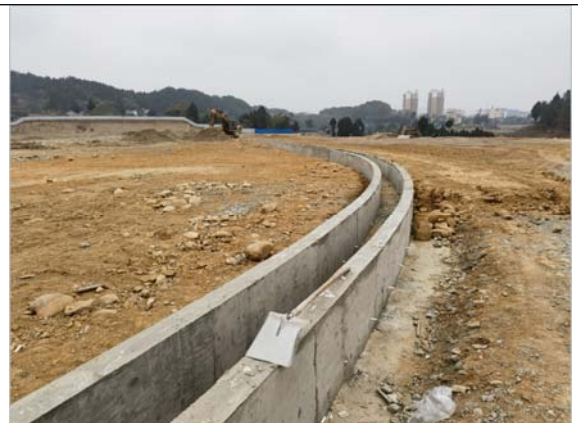
运动场排水沟建设现状 2022. 11. 30
