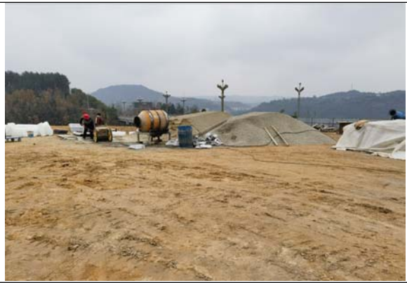
排水沟砼盖板加工场地
