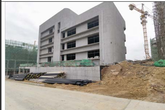
小学教学楼建设现状 2023. 04. 30
