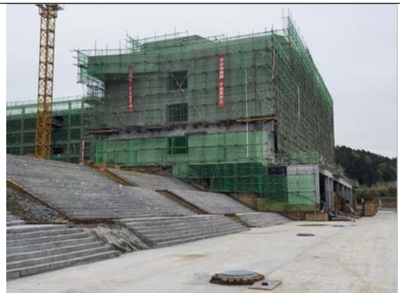
小学教学楼建设现状 2023.03.30
