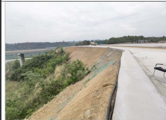
运动场东南侧填方边坡 2023. 04. 30
