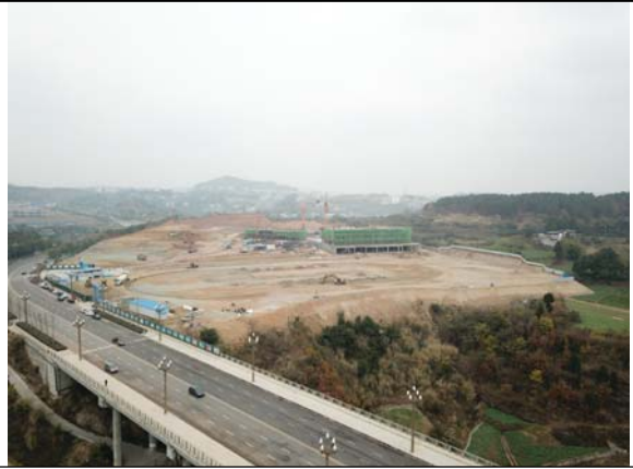
项目建设现状
