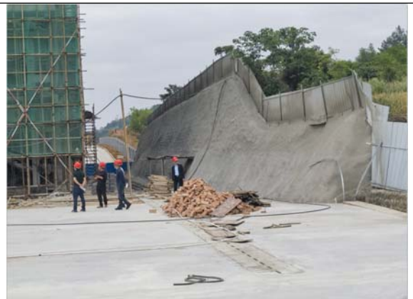
喷浆防护的运动场北侧挖方边坡 2023. 04. 30
