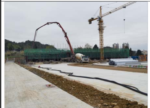
体育馆建设现状 2023.03.30
