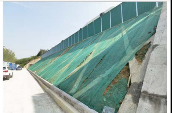
砼框格护坡绿化 2023.07.30
