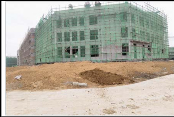
食堂建设现状 2023. 04. 30
