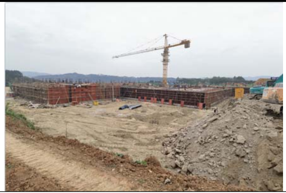
小学教学楼建设现状 2022. 11. 30
