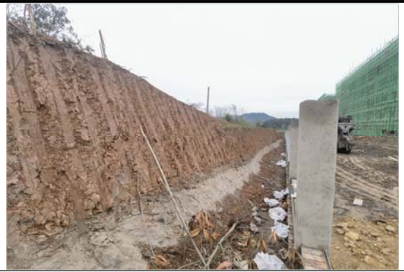
项目北侧开挖边坡现状 2023. 03. 30
