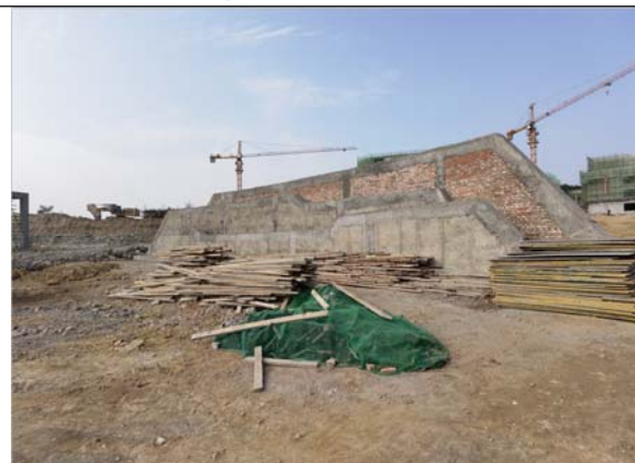
项目大门屏风建设情况 2023. 02. 28
