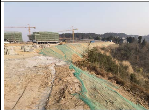
东南侧填方边坡遮盖 2023. 01. 30
