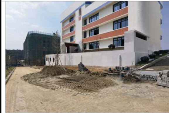
男生宿舍建设现状 2023.07.30
