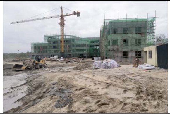
中学教学楼建设现状 2023. 04. 30
