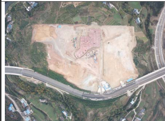
项目建设现状 2022. 11. 30
