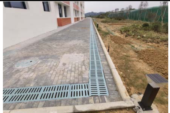
中学教学楼周边排水沟 2023.08.30
