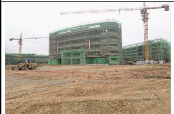
综合楼建设现状 2023.03.30
