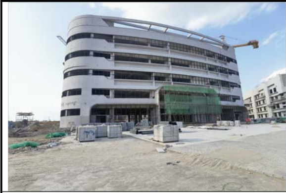
综合楼建设情况 2023.05.30
