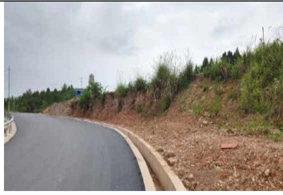
图 2-7 元陆 18 井入场道路
