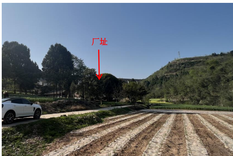
图 2-1 苍溪县百利新区污水处理厂厂址现状
