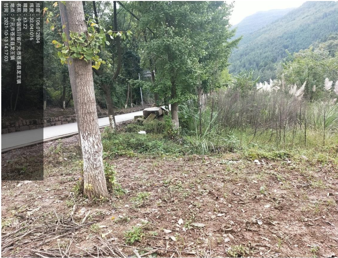
图 2-1 苍溪县龙王镇污水处理站建设现状
