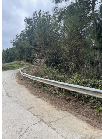
明阳村管道沿线道路
