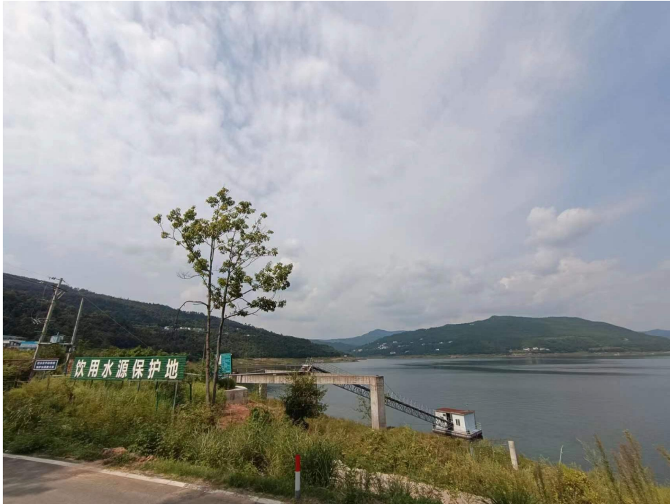
图 3-1 亭子镇水厂取水口
