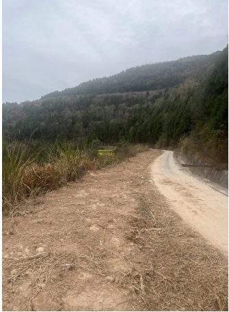
潜力村管道沿线道路
