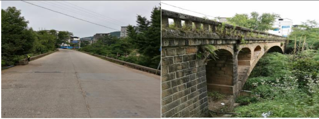
图8 道班桥平面照（左）和道班桥立面照（右）
